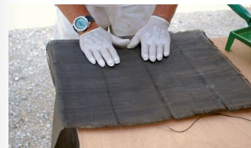
**3** Impregnare il tutto con altra resina impiegando generalmente dei rulli. Per favorire la distensione delle pieghe e la fuoriuscita dell'aria intrappolata spesso vanno impiegati particolari rulli frangibolle. L'adesione può essere non ottimale in zone di spigoli vivi che dovranno essere preventivamente arrotondati. In luoghi poco accessibili può essere utile un pennello ovalino. Per togliere l'eccesso di resina si può utilizzare una spatola o un rullino.
